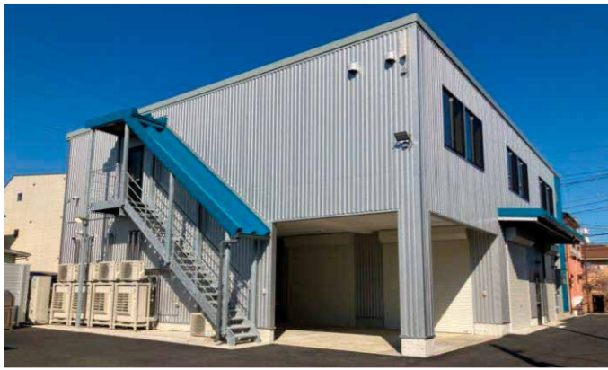
ケージェイリビング咲が丘事務所新築工事
