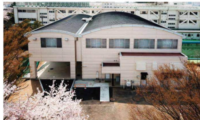
船橋市立宮本中学校ランチルーム増築工事
