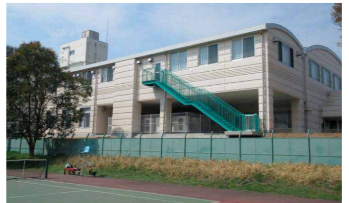
船橋市立宮本中学校ランチルーム増築工事
