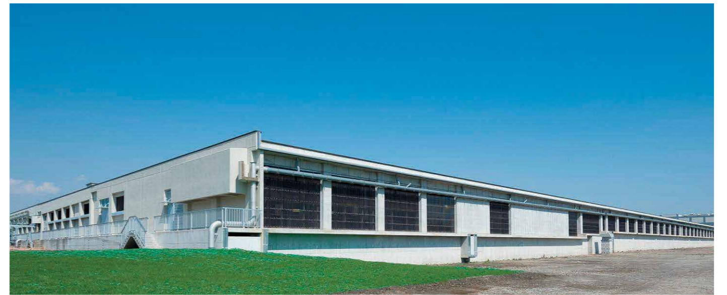
高瀬下水処理場建設工事 (JV)
