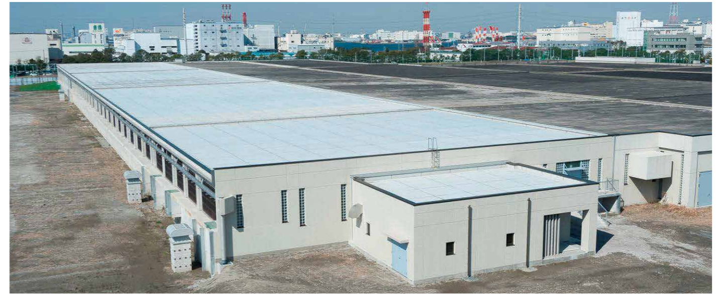
高瀬下水処理場建設工事 (JV)
