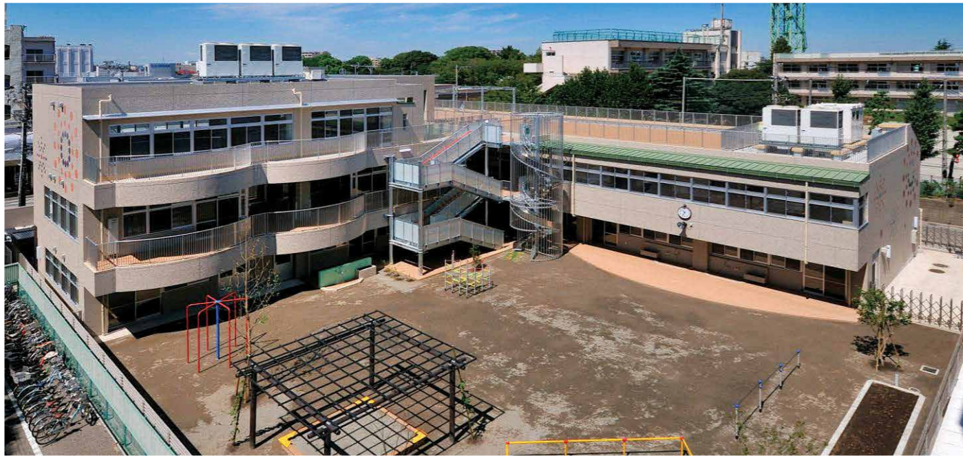
船橋市立習志野台第一保育園新築工事
