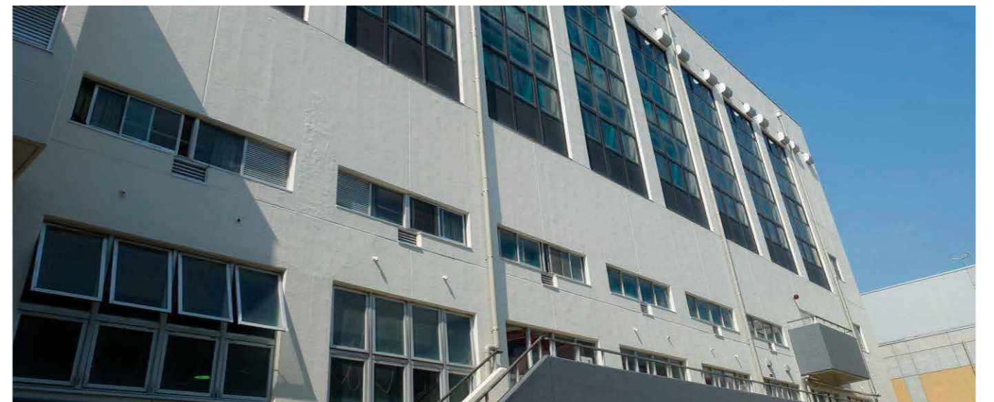
船橋市立船橋高等学校外壁剥落防止その他改修工事
