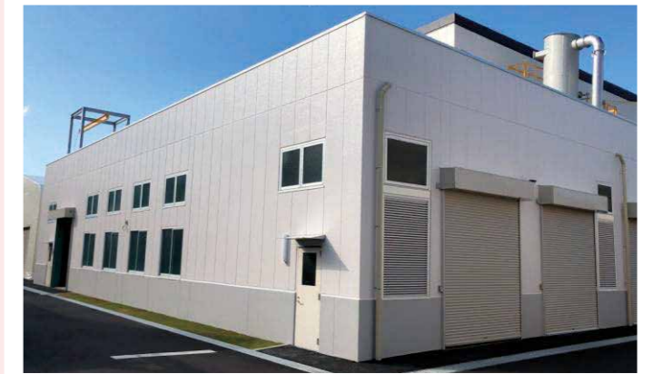
工場建築工事
