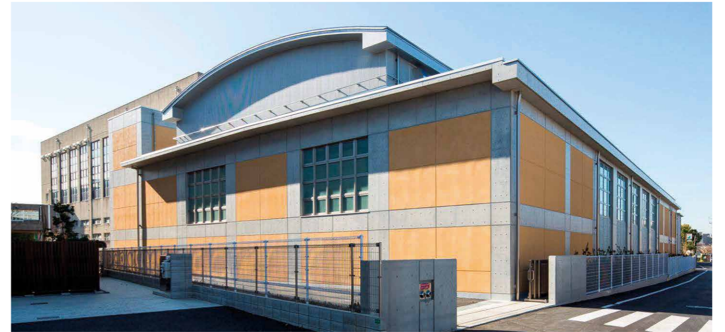
船橋市立船橋高等学校第3体育館新築工事 (JV)
