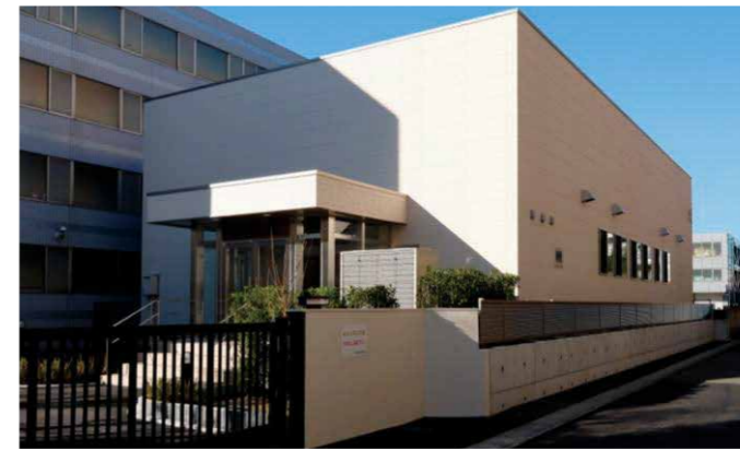
京葉ガス多目的施設新築工事
