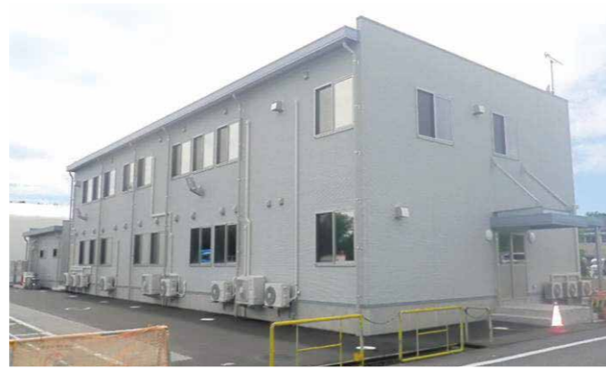
事務所更新工事
