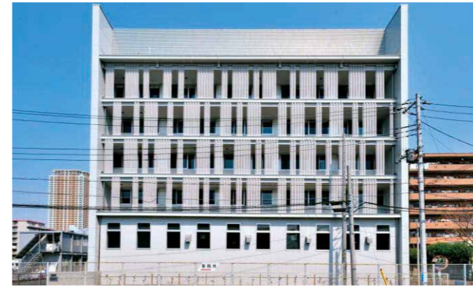
京葉ガス緊急保安研修センター建築工事
