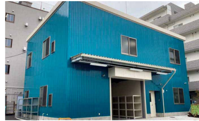
京葉ガス船橋ビル保安倉庫建替工事
