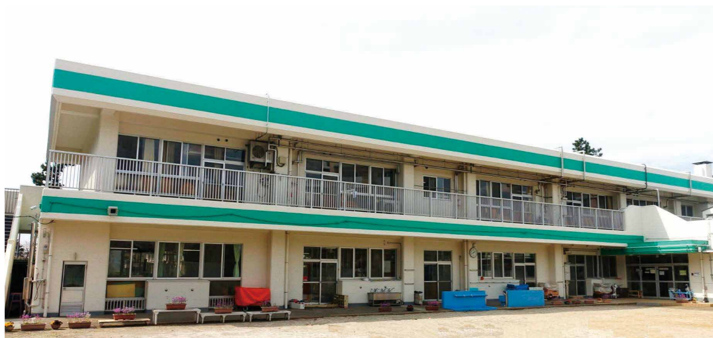
船橋市立高根台保育園外壁及び屋上防水その他改修工事
