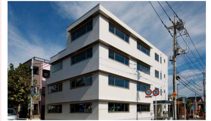
京葉ガス鎌ヶ谷ビル新築工事
