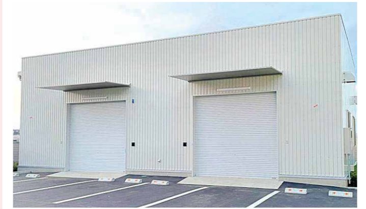
京葉住設倉庫新築工事
