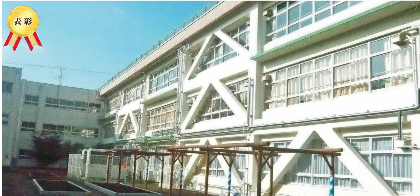
船橋市立三咲小学校校舎耐震補強工事
