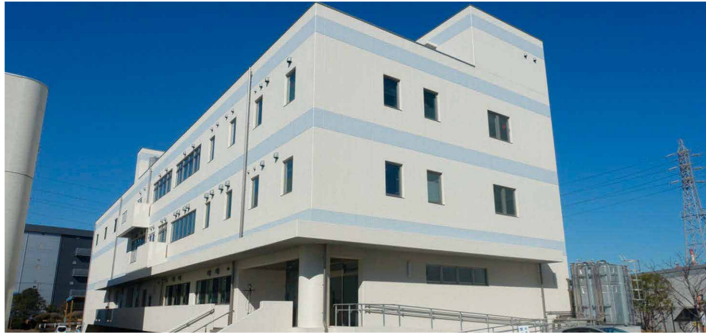
西浦下水処理場管理棟建設工事 (JV)
