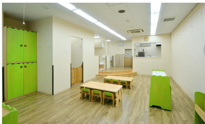
保育所内装工事
