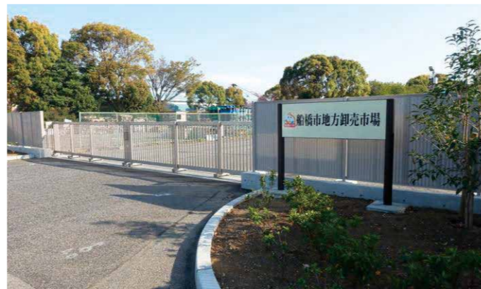
船橋市地方卸売市場北門西側塀他改修工事
