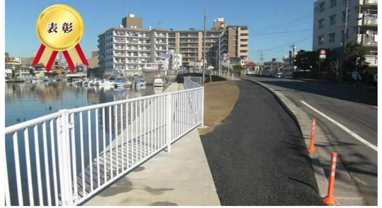
護岸整備工事
