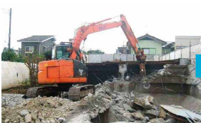
浄化槽撤去工事
