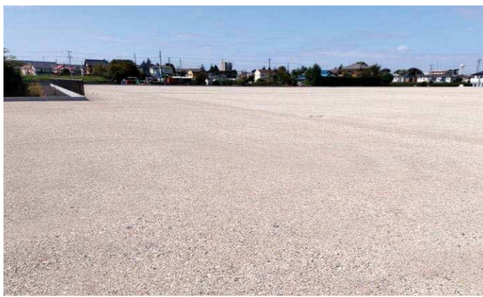
敷地内造成工事
