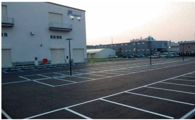
駐車場整備工事
