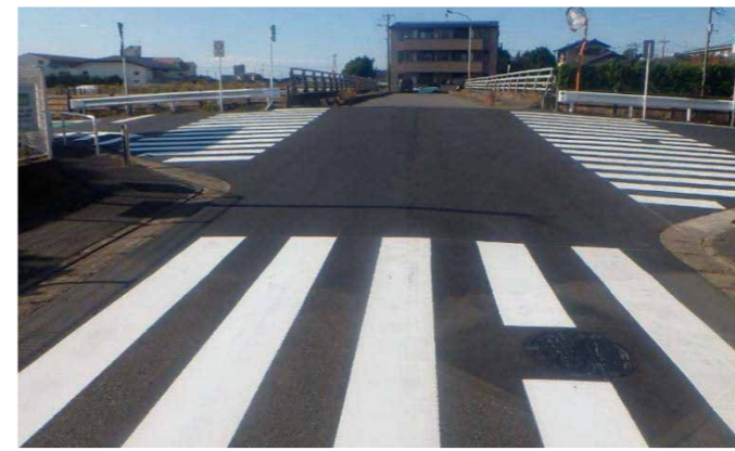
道路復旧工事
