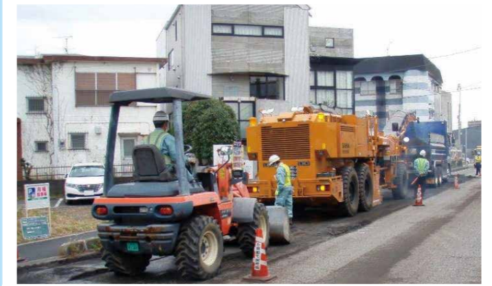
道路復旧工事
