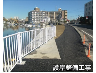
護岸整備工事
