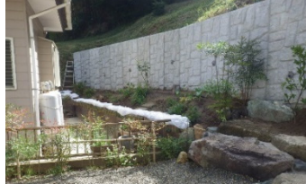
社宅敷地内法面崩壊対策工事
