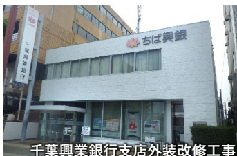
千葉興業銀行支店外装改修工事
